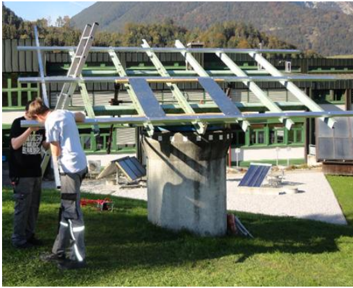
Abbildung 12: Montage der Tragekonstruktion
