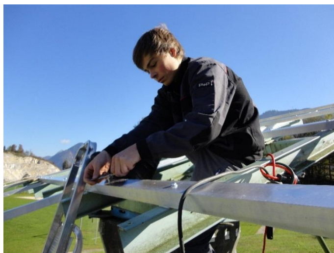
Abbildung 14: Schüler beim Schneiden des Innengewindes
