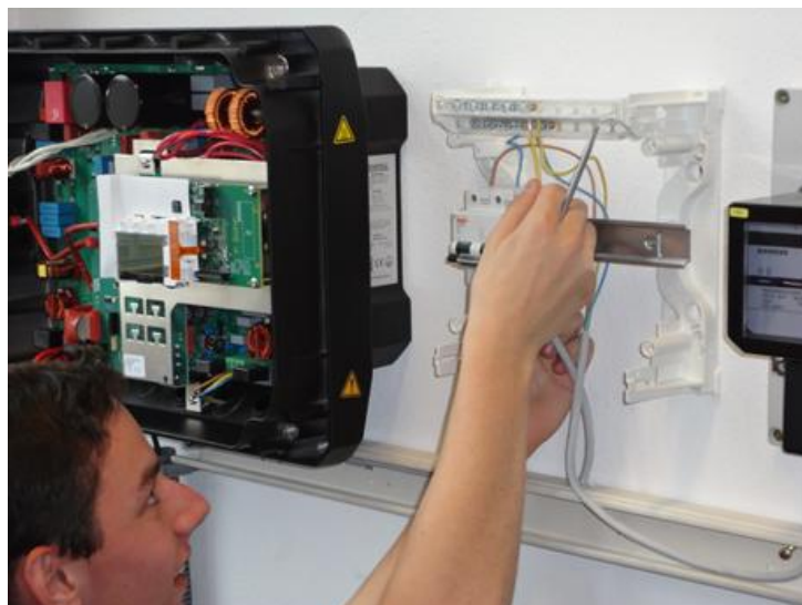
Abbildung 17: Anschluss der Einspeisung
