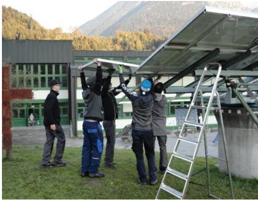
Abbildung 15: Montage der Module
