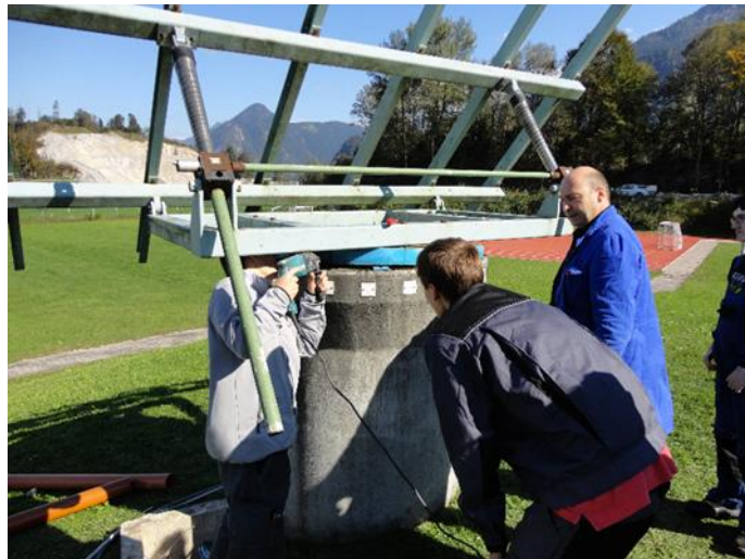
Abbildung 8: Schüler bei der Instandsetzung des Drehkranzes
