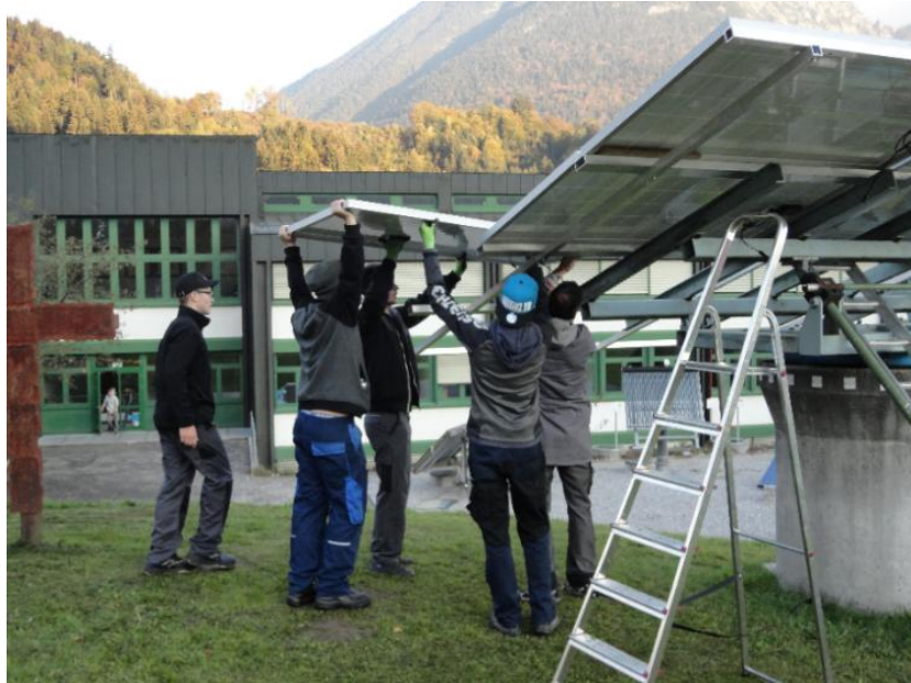
Abbildung 1: Montage der Solarmodule
