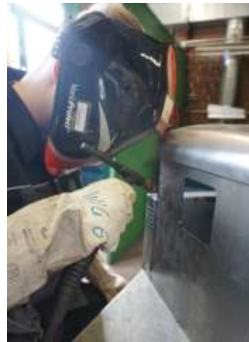
Abbildung 4: Schweißarbeiten an der Fahrkabine
